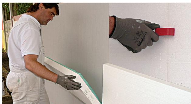
Ďalším krokom je samotné prisadenie dosky k podkladovej konštrukcii, pričom medzera medzi podkladom a izolačnou doskou je vymedzená profilmi *TermoStick*. Spojie dosiek je možné zaistiť pomocou *TermoClip*.
