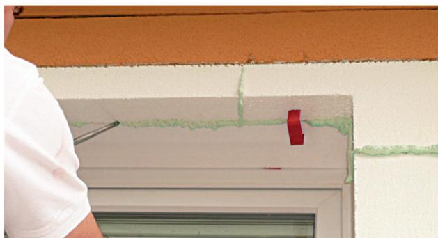
V prípade potreby je možné na fixáciu dosiek v mieste nadväznosti tepelného izolantu popr. nadpražia použiť *TermoClip*. Prípadné vzniknuté škáry v stykoch dosiek sa vyplnia polyuretánovou penou.
