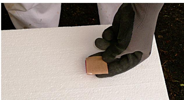
Najprv sa osadia 4ks lepiacich profilov *TermoStick* pri štandardnej doske a 2ks pri použití špeciálnej dosky opatrené systémom s pero - drážkou. Použitie tejto dosky prispieva k ešte efektívnejšiemu zrýchleniu systému. Medzi doskou izolantu a lepiacim profilom vymedzujeme medzeru zhruba na hrúbku prsta, tá nám zaručí plnú lepiacu schopnosť.
