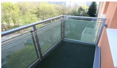
**Paropriepustný balkónový koberec** z gumových granulátov spojených polyuretanovým spojivom (pre zvýšenie komfortu a povrchovú ochranu náterov podlahy proti oderu) umožňuje voľné odtekanie zrážkovej vody z povrchu koberca i balkónu. Dodáva sa v rôznych farbách podľa katalógu výrobcu.
